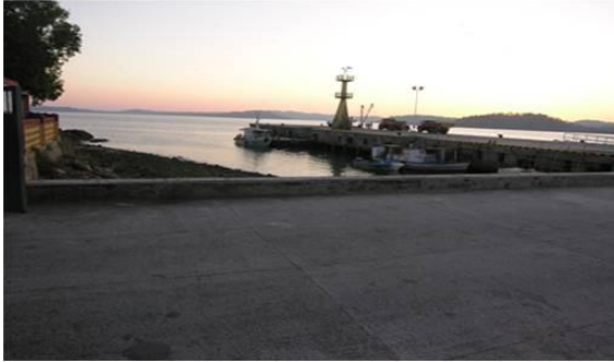
25. Arial Bay Jetty
